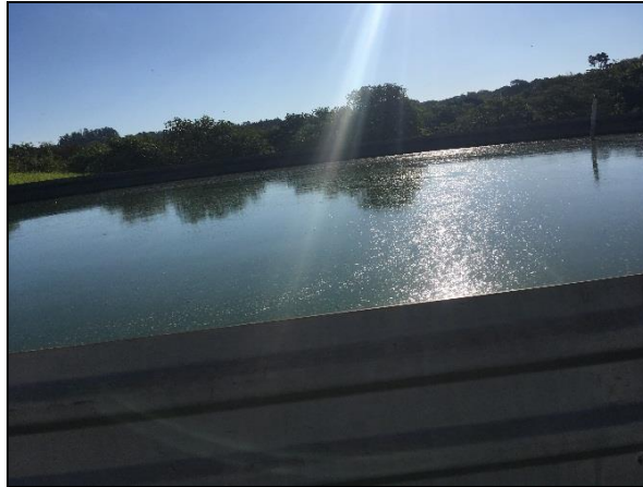
Fotografia 3 - Taque de captação de água
